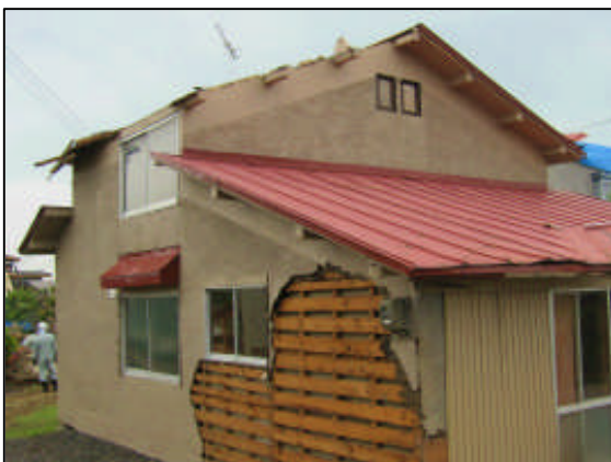
C 5 トタン屋根および外壁が剥離し飛 散した住家 （西から撮影）
