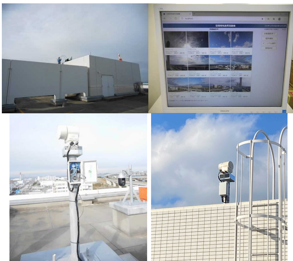
空港用気象実況画像取得装置の更新（中部空港事務所庁舎：2023年12月）
