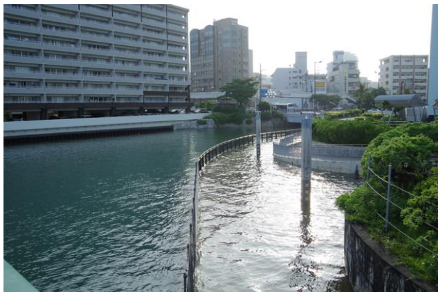
水没した遊歩道 (那覇市)
