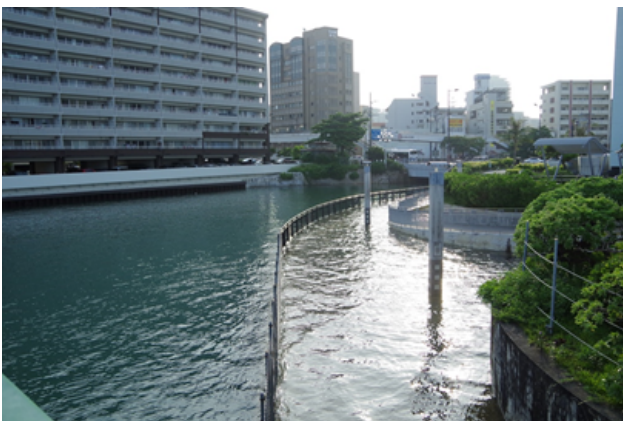
水没した遊歩道
