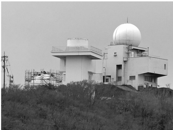
新レーダーの土台横でドーム製作中 (2020年11月23日撮影)
