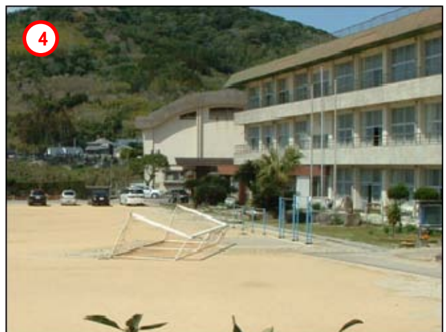
④ サッカーゴールが校舎側（北北東側）に転倒
