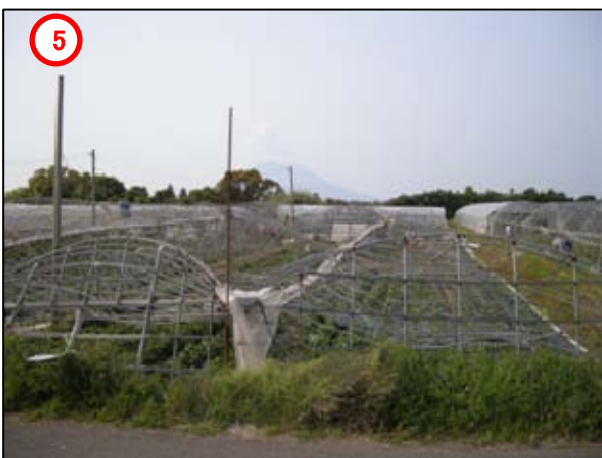
ビニールハウスが北側に倒壊
