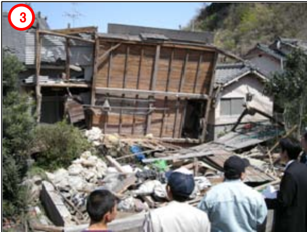
非住家が基礎部分を残して北側に転倒
