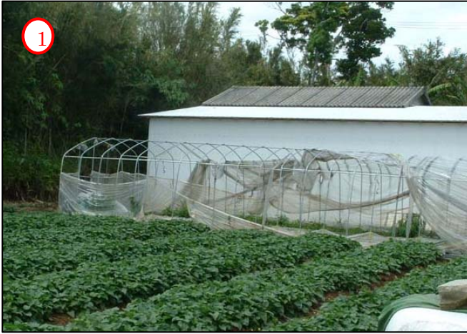
ビニールハウスのビニールが めくれていた
