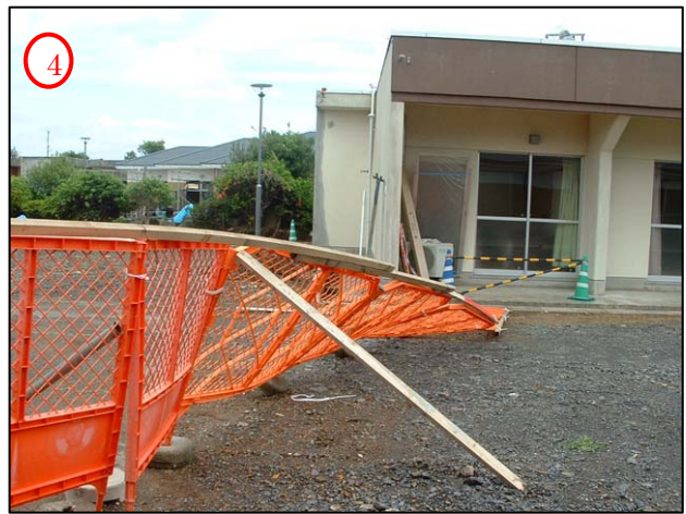
老人ホーム内の 工事用フェンス
