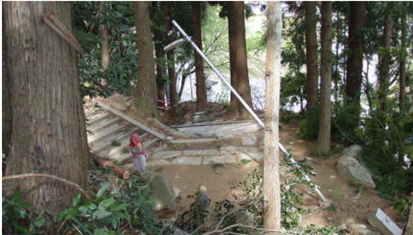
④－２ 油井地区長谷観音 電灯柱が転倒。
