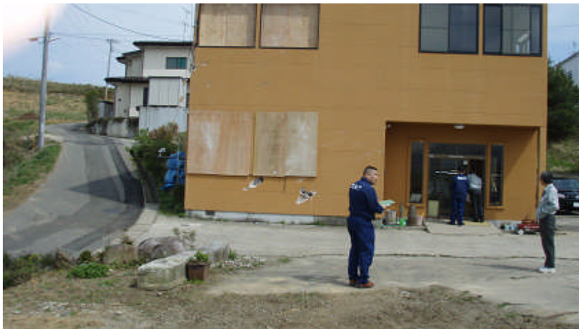
⑤－１ 油井字松葉山 手前更地にあった物置小屋が北東に 15m程飛び、事務所にぶつかり全壊。事務所は窓ガラス、外壁の一部損壊。
