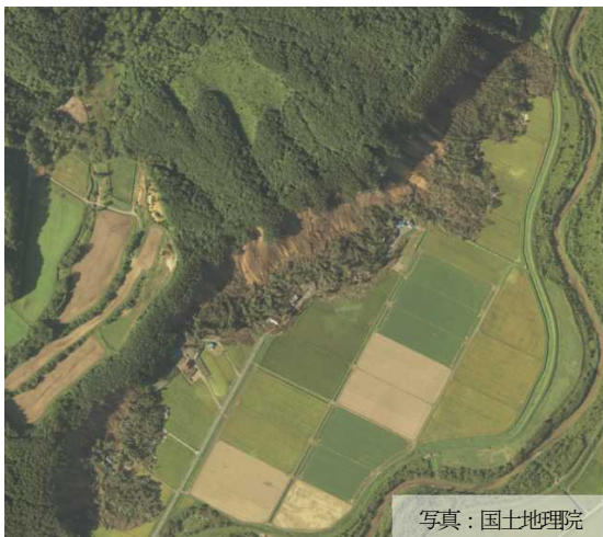
平成30年北海道胆振東部地震 地震発生後
