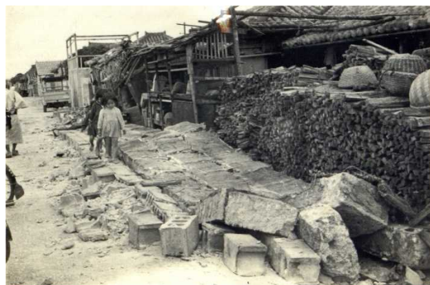
1958 年 3 月 11 日石垣島北東沖地震による被害
