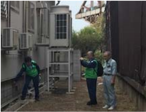
写真 3 : 浸水痕跡調査 (堺泉北港湾事務所)
