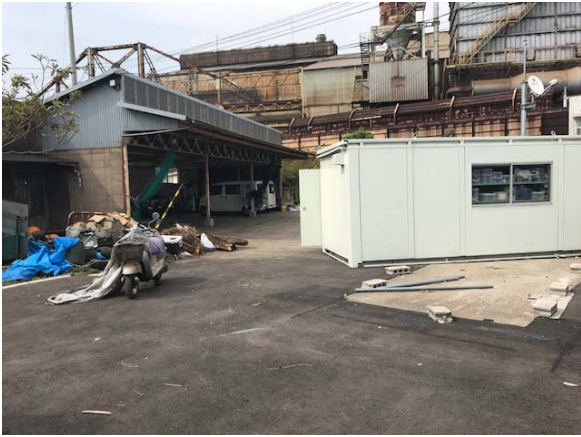
写真 1 : 調査時の堺泉北港湾事務所車庫付近 (右側の白い倉庫が土台から移動)
