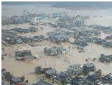
浸水状況（豊岡市）
