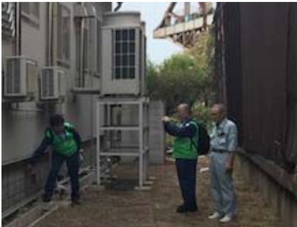
写真3：浸水痕跡調査（堺泉北港湾事務所）
