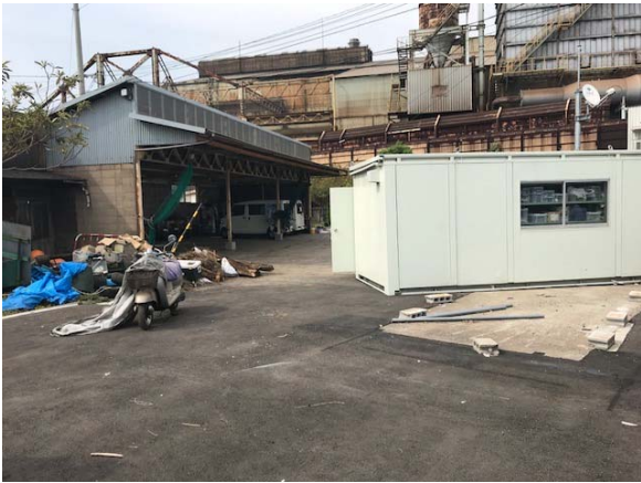
写真1：調査時の堺泉北港湾事務所車庫付近 (右側の白い倉庫が土台から移動)
