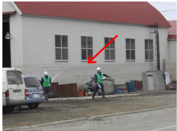
写真2 豊頃町大津漁港 造船所倉庫に残る津波の痕跡（写真中矢印）。
