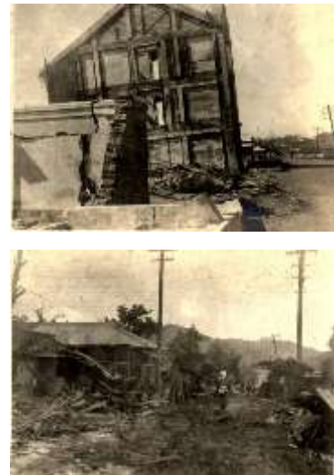
被害状況の写真
