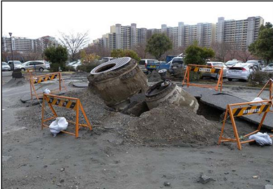
平成 23 年 (2011 年) 東北地方太平洋沖地震 液状化によるマンホールの被害 (浦安市)
