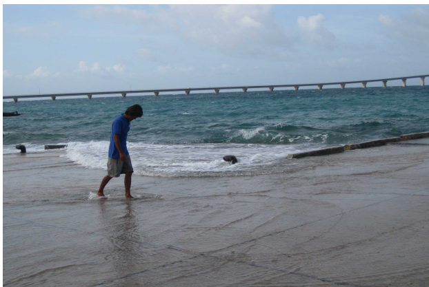
平成 21 (2009) 年の下地前浜港の冠水の様子
