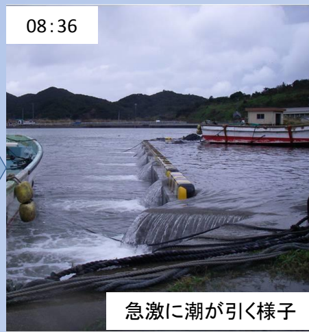
岸壁冠水の様子
