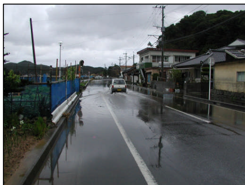
3：上甑町小島の道路冠水
