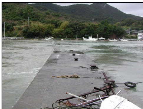
4：冠水した浦内湾防波堤
