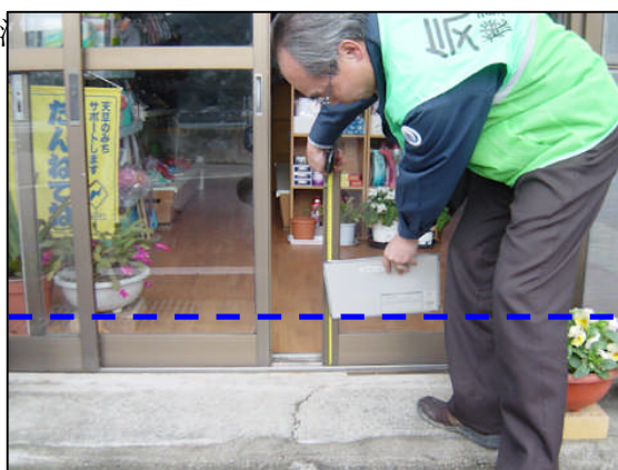
1 : 崎津での床下浸水 (0.2m)
