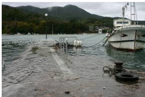
写真1 副振動の影響で冠水した突堤(A地点) (薩摩川内市上甑支所提供)
