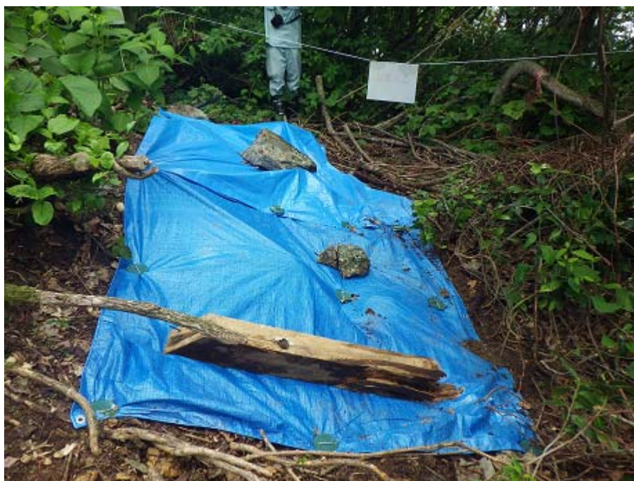
写真 飛散防止のための応急処置の状況
