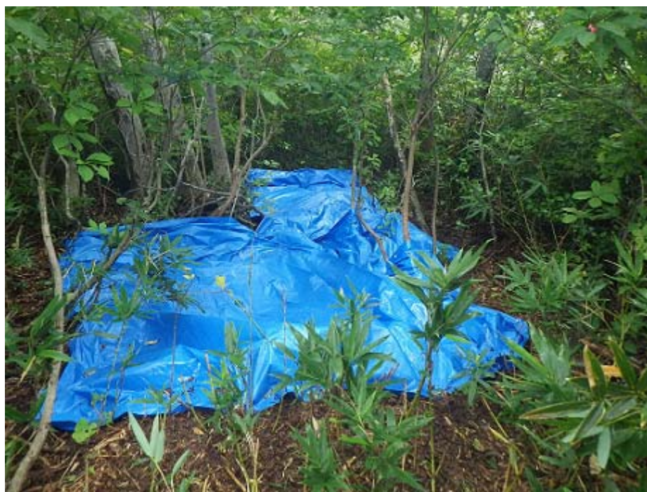
写真 飛散防止のための応急処置の状況
