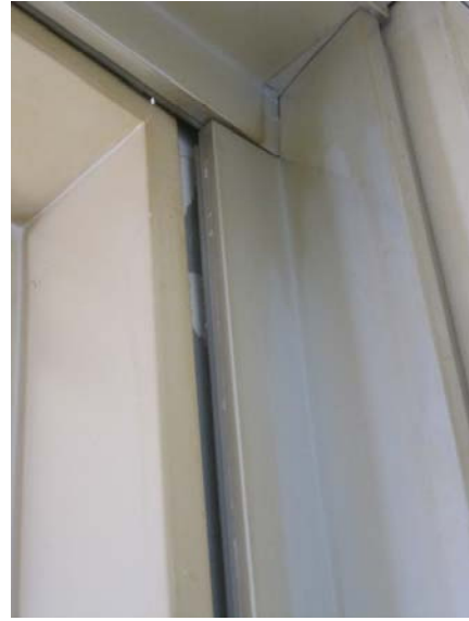
写真24 庁舎ゆがみのためドア部分に 生じた隙間・写真1の拡大 (新潟県十日町市水口沢)
