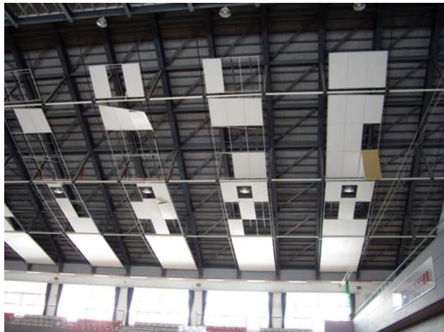
写真 2 2 松代総合体育館の天井パネルの 落下 (新潟県十日町市松代)
