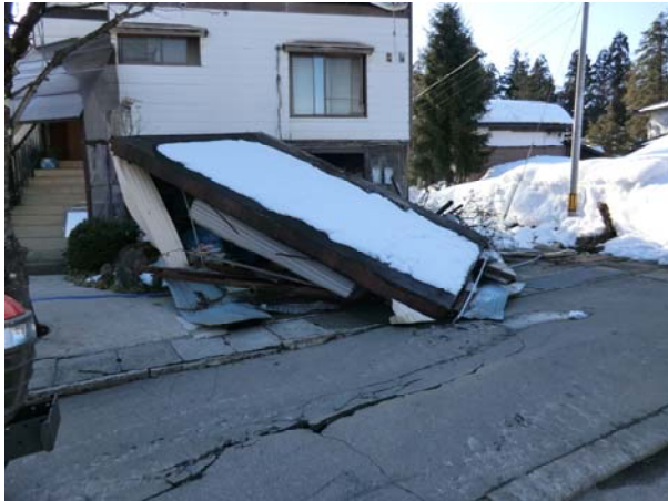
写真 1 3 民家の車庫の倒壊 (長野県栄村)
