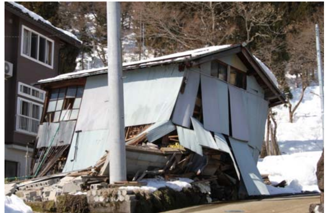
写真10 津南町小島 倉庫の倒壊 (新潟県津南町：津南町提供)
