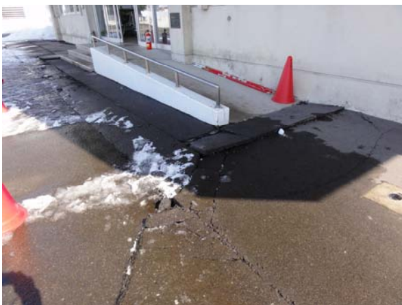
写真5 十日町市上山中里公民館車いす用スロープ 出入口付近の地割れ (新潟県十日町市上山中里)
