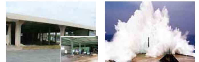
平成 18 年台風第 13 号 (サンサン) による高波で破壊された港湾施設 (沖縄本島北部)、右は南大東島の高波
