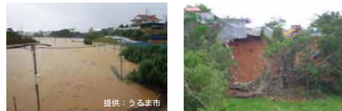
平成 26 年台風第 8 号 (ノグリー) による本島中部での被害
