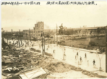
図 5. 府立大阪測候所鉄塔 3 基倒壊
