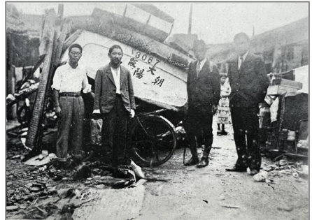
図 6. 大阪支台観測船朝陽丸の被害
