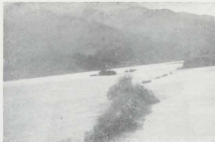
勝浦川堤防の決壊 (徳島県勝浦郡生地奈村) (徳島測候所撮影)
