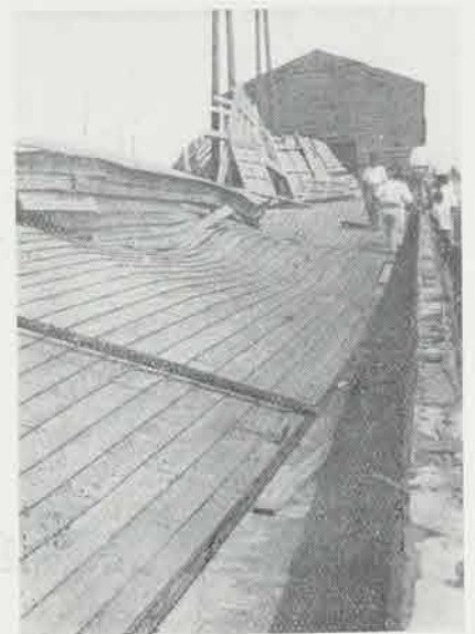
名古屋港務所倉庫倒壊 (名古屋地方気象台撮影)
