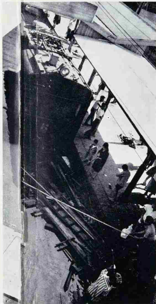
大阪環状線西九条駅付近の高潮被災 (大阪管区気象台広報係撮影)
