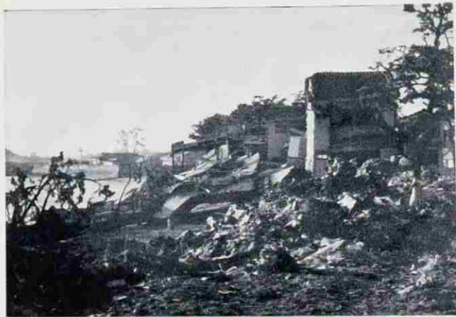
高波による和歌山県田辺市海浜の 旅館の被害 (和歌山地方気象台撮影)
