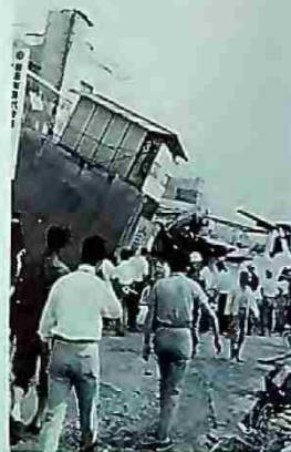
神戸市 宇治川筋のビルの傾斜、倒壊 (神戸海洋气象台)
