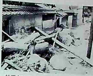
神戸市生田区北野町3丁目附近 土砂、石塊、流木による被害状況 (神戸海洋气象台)
