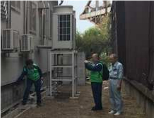
写真 3 : 浸水痕跡調査 (堺泉北港湾事務所)
