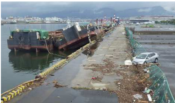
写真 5 : 調査時の西宮市甲子園浜海浜公園付近
