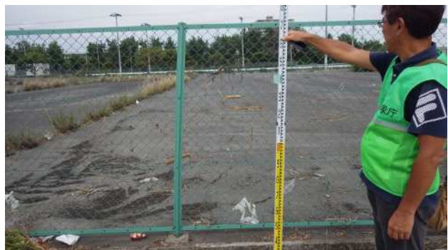
写真 6 : 水準測量実施 (西宮市甲子園浜海浜公園付近)
