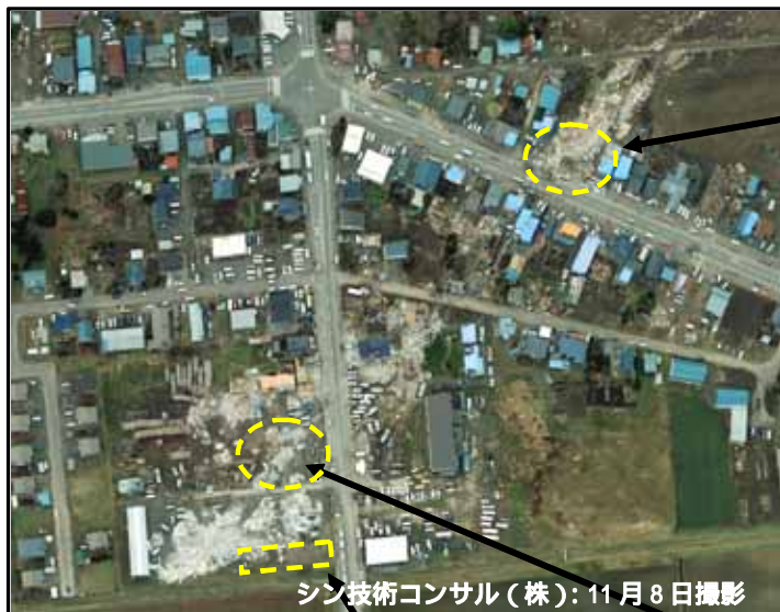
被災後の上空写真
