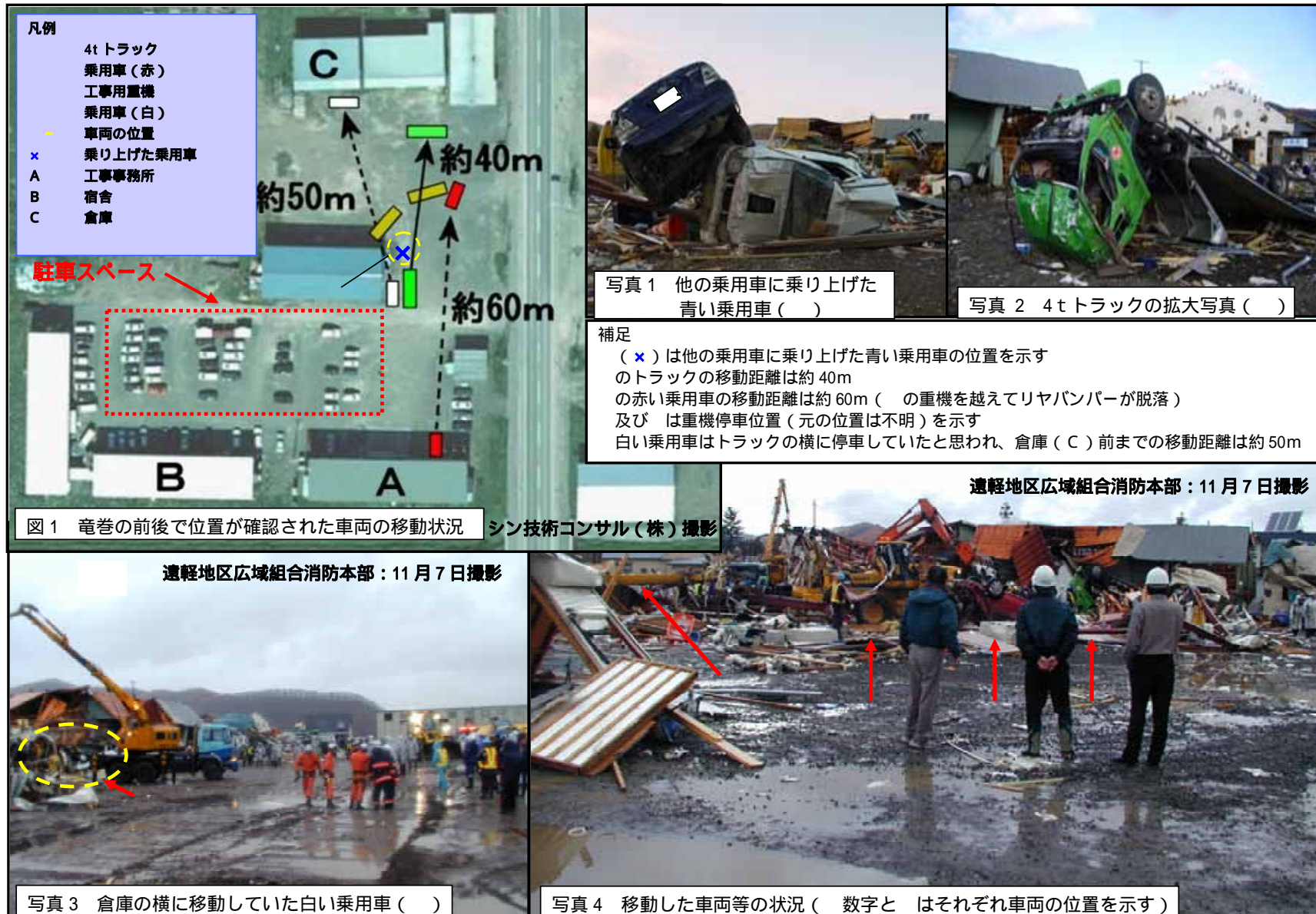
図 2-4 トンネル工事事務所駐車場付近の車両の移動と損壊状況
