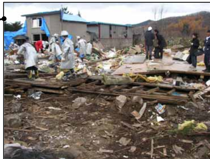
写真1 倒壊した住家跡
