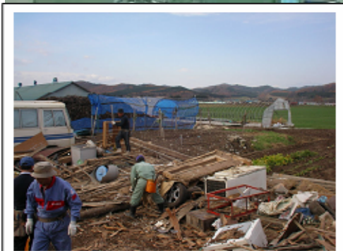
損壊した物置（片付け後）
