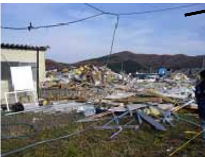
トンネル工事事務所(プレハブ)跡 人命救助のため瓦礫は移動した後
