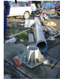
倒壊した道路標識 (網走開発建設部提供)
