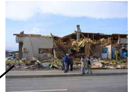
損壊した事務所
