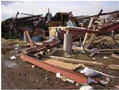
倉庫跡 鉄骨が曲がっている
