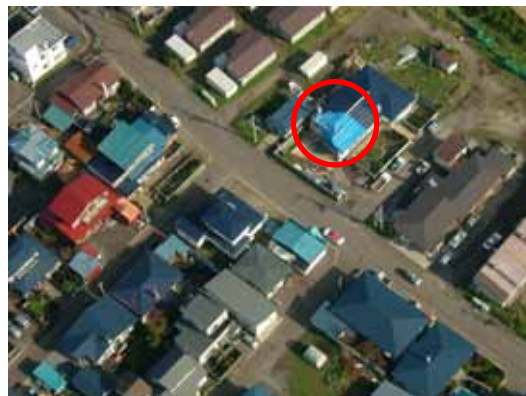
図 3-4-4 屋根が吹き飛ばされた住居兼倉庫（A さん宅：印）
