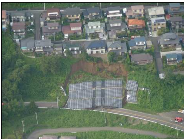
仙台市太白区羽黒台の土砂災害 (仙台市消防局提供)
