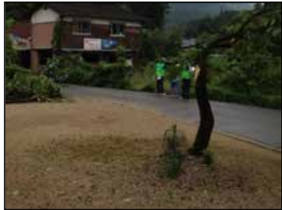
[4] 幹折れした細い樹木(樹種: 柿 / 撮影方向: 北)
