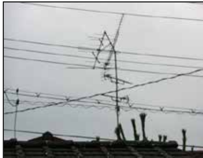
[15] 折損したアンテナ(撮影方向:南)
