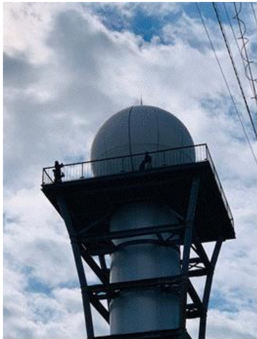
牧之原気象レーダー観測所外観
