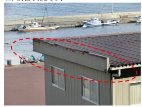
図 4-① トタン屋根の袖部上端がめくれた非住家
