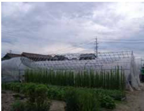
日吉津村日吉津 ビニールハウス (東端) の損壊
