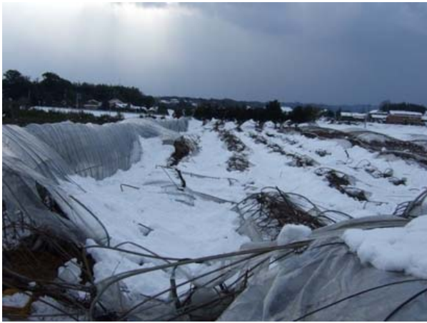
写真 1 ぶどうハウスの倒壊 (琴浦町)
