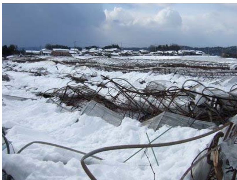
ぶどうハウスの倒壊（琴浦町） 鳥取県農政課提供
