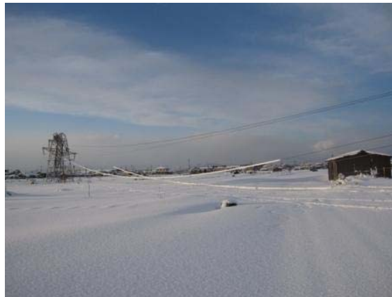
垂れ下がった送電線（中国電力提供）
