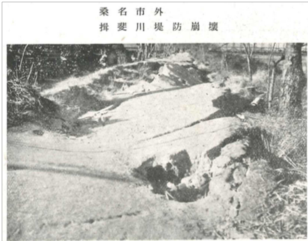
旧桑名市外における揖斐川堤防決壊の写真
