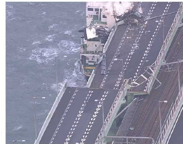
提供：国土交通省近畿地方整備局 関西国際空港連絡橋 2018年09月04日
