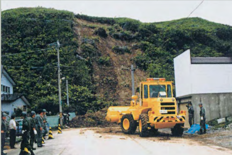
稚内市恵比須のがけ崩れ現場（稚内市提供）
