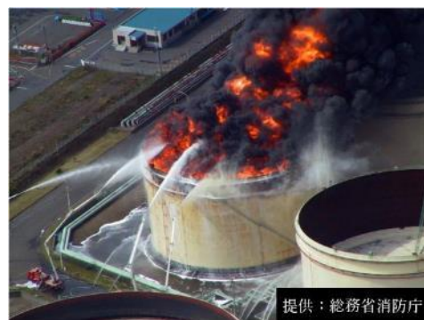
図3 大型タンク類の被害
