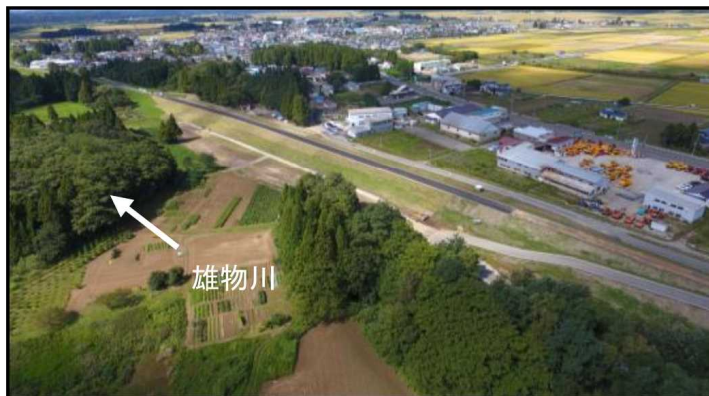
堤防完成（令和元年9月25日撮影）
