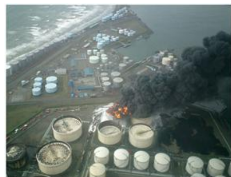
図3 石油タンクの被害（総務省消防研究センター提供）
