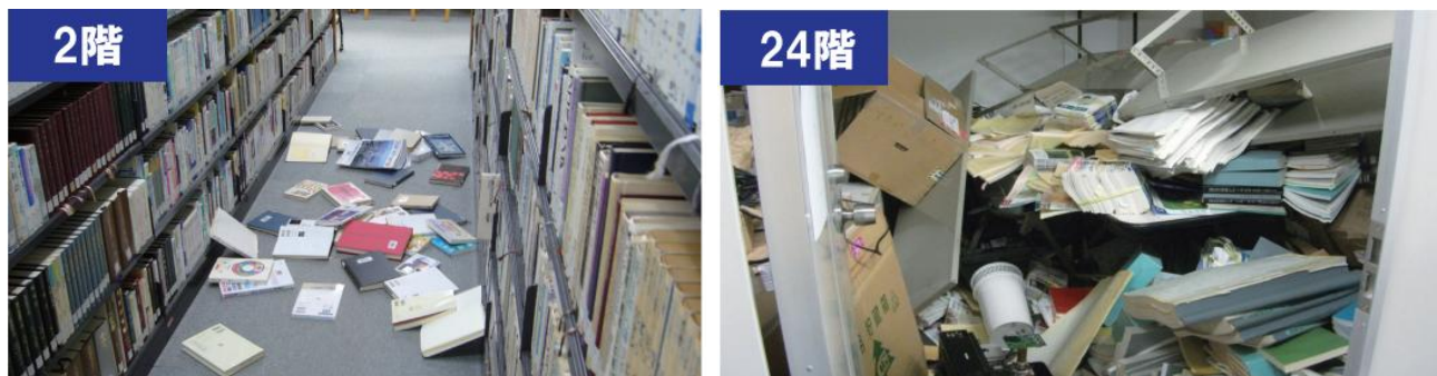
図2 東京都内の同一ビルにおける低層階と高層階の被害状況（工学院大学提供）
