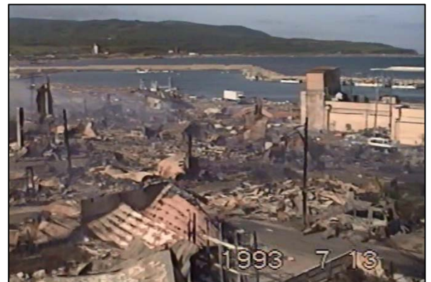
写真 4 地震後の青苗東側市街地
