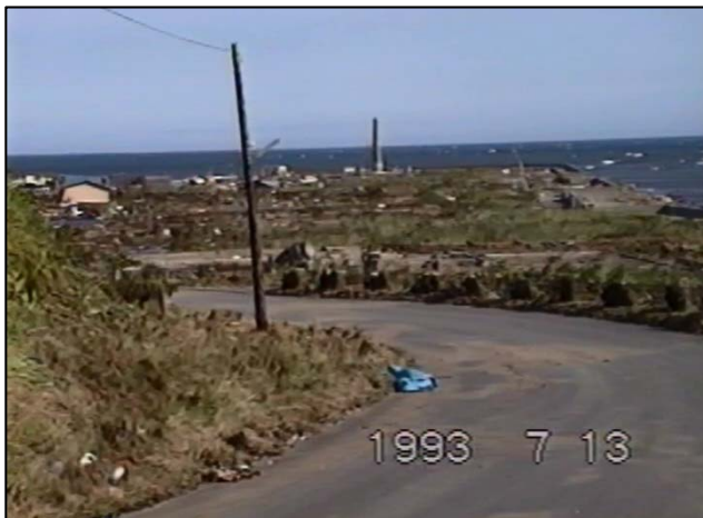
写真 1 青苗地区南側市街地 津波襲来後の写真。数十軒あった家が 津波により流された。
