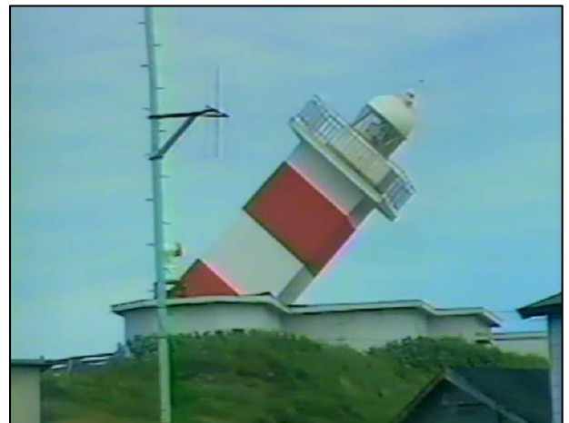
写真 2 青苗灯台 鉄筋コンクリート製の灯台が倒壊。
