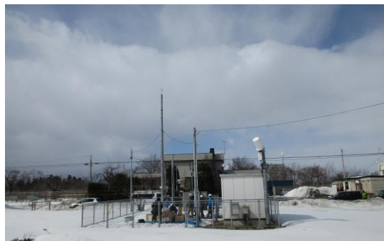
アメダス更新工事の様子（弘前）
