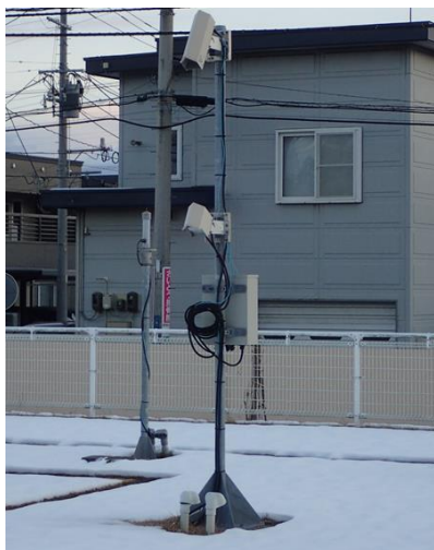
青森地方気象台の露場に設置している「レーザー式積雪計」。
