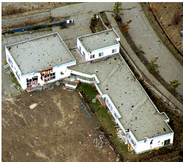
2000年有珠山噴火による噴石被害 (岡田弘氏提供) 2000年(平成12年)4月16日撮影
