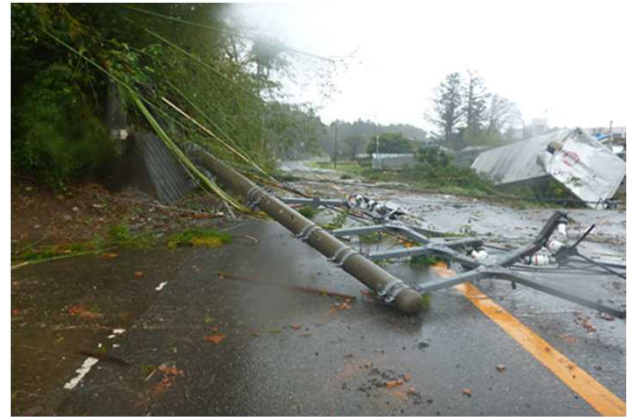
④ 倒壊した電柱 (東方向から撮影)
